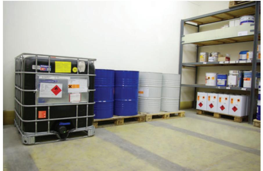
Abb.: GFK-Raumauskleidung eines Chemikalienlagers
