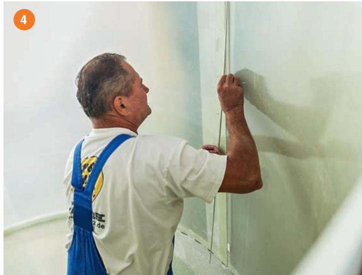
Installation der Überwachungsleitung für die Vakuum-Leckanzeige.
