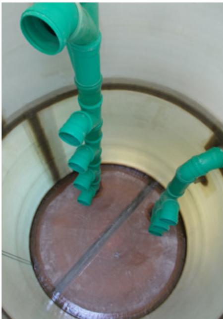
Das Schichtenladesystem in der Dimension DN 300 sorgt für die temperaturabhängige Beladung des Speichers
