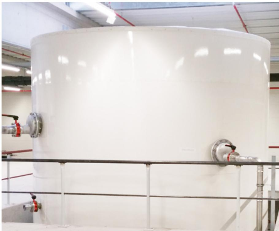
Der Wärmespeicher mit einem Volumen von 79.000 Litern erstreckt sich aufgrund seiner Höhe von 6,80 m über 2 Etagen des Gebäudes
