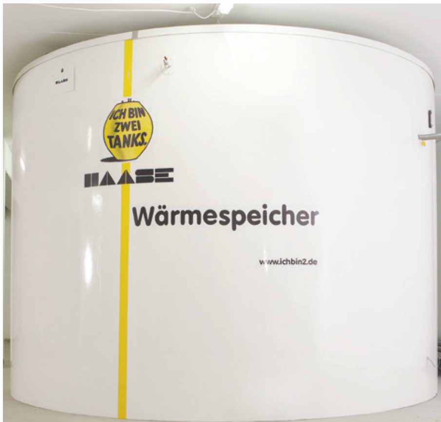
Der Großspeicher (Typ T 440-293) mit einem Durchmesser von 4,40 m und einer Höhe von 2,80 m hat ein Volumen von 30.000 Liter.
