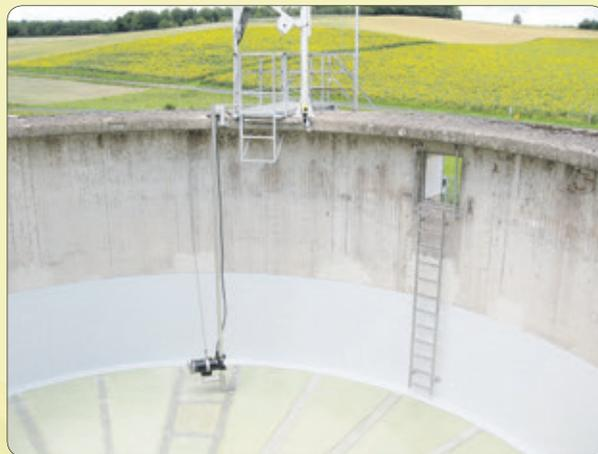
Durch die genoppte Unterseite der GFK-Lamine werden mögliche Unebenheiten des Untergrunds ausgeglichen. Auf Kundenwunsch kann eine Schutzlackierung aufgetragen werden.
