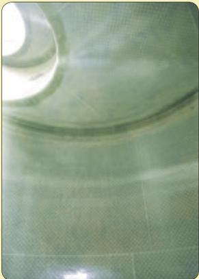
Die Platten aus GFK werden werksseitig vorkonfektioniert. Auf der Baustelle werden dann nur noch die Verbindungsstellen laminiert – das spart Zeit und damit Geld.
