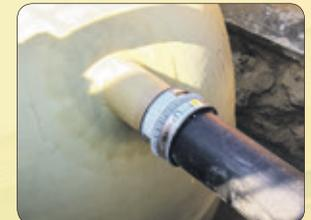
Zu- und Ablauf sind beim Haase-Abscheider dicht einlamiert und werden mit zugelassenen, gelenkigen Rohrverbindungen mit den Abwasserleitungen verbunden.
