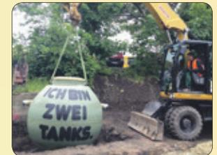
Dank des geringen Gewichts und der kompakten Bauform kann der Einbau schnell und unkompliziert durchgeführt werden.
