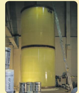
Je nach Anforderungen sind Höhen zwischen 1,50 m und 8,90 m sowie Durchmesser von 1,30 m bis 4,40 m möglich.
