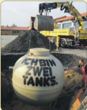
Auf Kundenwunsch kann der Abscheider durch ein firmeneigenes Spezialfahrzeug direkt in die Baugrube eingesetzt werden.
