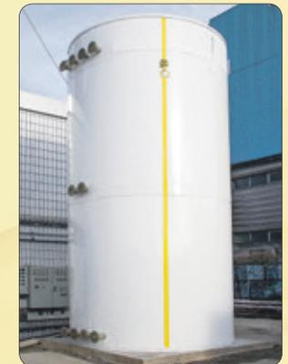
Haase-Wärmespeicher können sowohl innerhalb von Gebäuden als auch außerhalb installiert werden.
