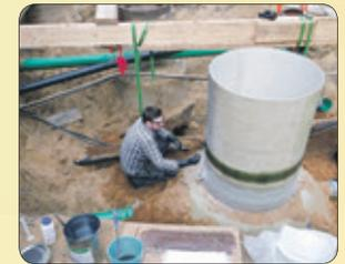
Der Schacht kann vor Ort fugenlos auf die gegebene Einbautiefe angepasst werden.
