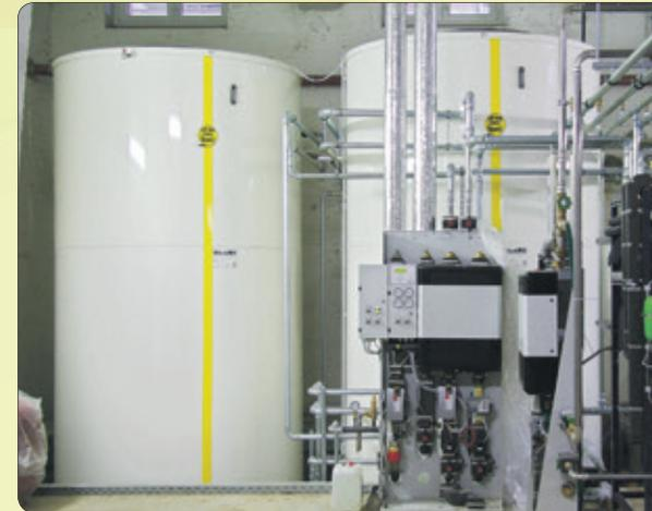
Die Be- und Entladung kann sowohl über Flansche, interne Wärmetauscher oder auch Schichtenladesysteme erfolgen
