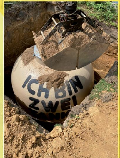
\* Wegen des Platzbedarfs des Entnahmesystems beträgt der nicht befüllbare Raum bis ca. 10 % des Tankvolumens. Pellets bilden einen Schüttkegel, deshalb ist eine Restmenge von bis ca. 15 % des Tankvolumens möglich, die durch das Entnahmesystem nicht aus dem Tank befördert werden kann.
