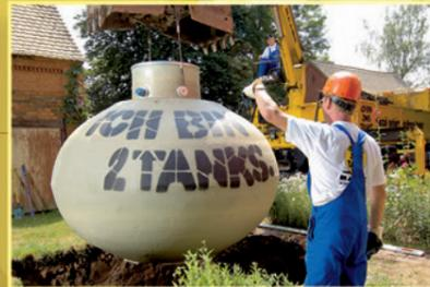
Pelletserdtanks von Haase bestehen aus hochwertigem GFK (glasfaserverstärkter Kunststoff). Dieses Material zeichnet sich durch absolute Korrosionsfreiheit, Formstabilität und Alterungsbeständigkeit aus. Die Innenwand des Tanks ist zusätzlich mit einer elektrisch leitfähigen Oberfläche versehen, wodurch eine elektrostatische Aufladung vermieden wird.
