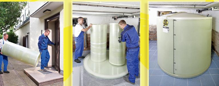
Vor-Ort-Montage: Der Kellertank wird in Einzelteilen geliefert und erst vor Ort montiert.
