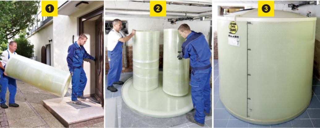
Der Kellertank wird in Einzelteilen geliefert und vor Ort montiert.
