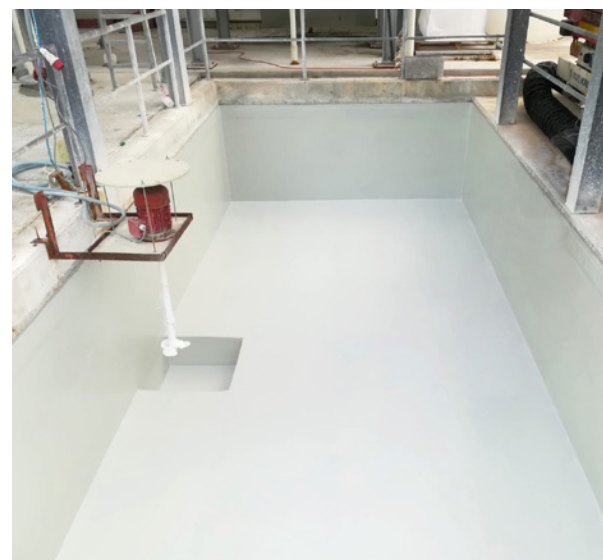
Betonbecken mit Pumpensumpf (Harzgruppe 7A, CSS3, 3 mm, beschichtet)
