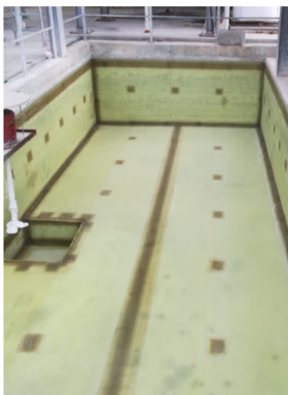
Betonbecken mit Pumpensumpf (Harzgruppe 7A, CSS3, 3 mm, beschichtet)
