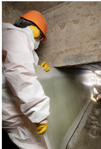
Auskleidung für Regenwasserkanal (Harzgruppe 1B, Stärke des Noppenlaminats 3 mm, umlaufend angeschliffen)
