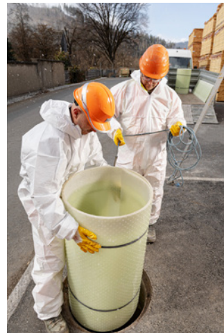
Auskleidung für Regenwasserkanal (Harzgruppe 1B, Stärke des Noppenlaminats 3 mm, umlaufend angeschliffen)
