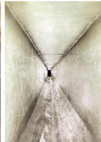
Auskleidung für Regenwasserkanal (Harzgruppe 1B, Stärke des Noppenlaminats 3 mm, umlaufend angeschliffen)
