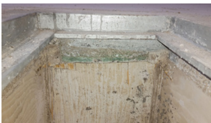
Fixpunktauskleidung für Ablaufrinnen und Pumpensümpfe (Harzgruppe 7A, CSS1, Stärke des Noppenlaminat 3 mm)
