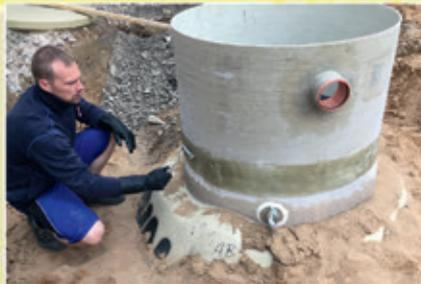
Diese Konstruktion sorgt für die **dauerhafte Dichtheit** des Behälters, sowohl von innen als auch von außen. Durch diesen **speziellen Wandaufbau** kombiniert der GFK-Abscheider die **chemische Beständigkeit** von Kunststoff mit der **Stabilität** von Beton in sich.
