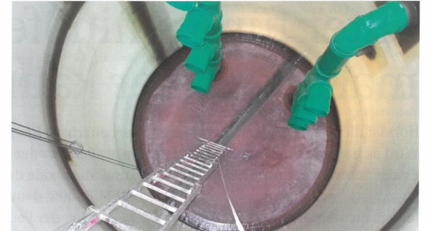
Blick in den Abwärmespeicher. Gut zu erkennen sind die Flansche für die einzelnen Temperaturniveaus.
