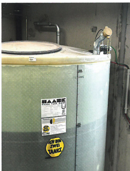
Im Haase-Tank befindet sich eine sichere Energiereserve, und falls die Hackschnitzelheizung mal ausfällt springt der Ölkessel ein.
