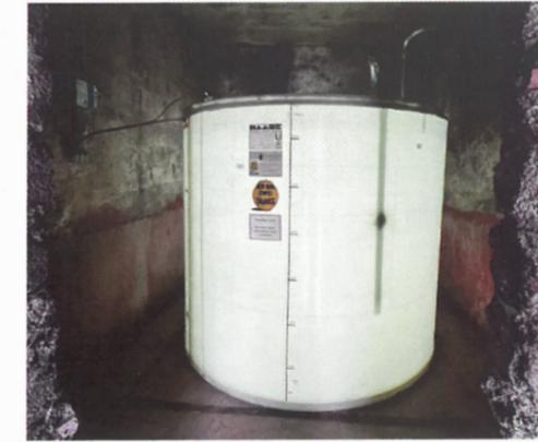
Perfekt eingepasst. Die Feuchtigkeit kann dem GFK-Material – im Unterschied zum Stahltank – nichts anhaben, der Füllstand ist von außen gut sichtbar.
