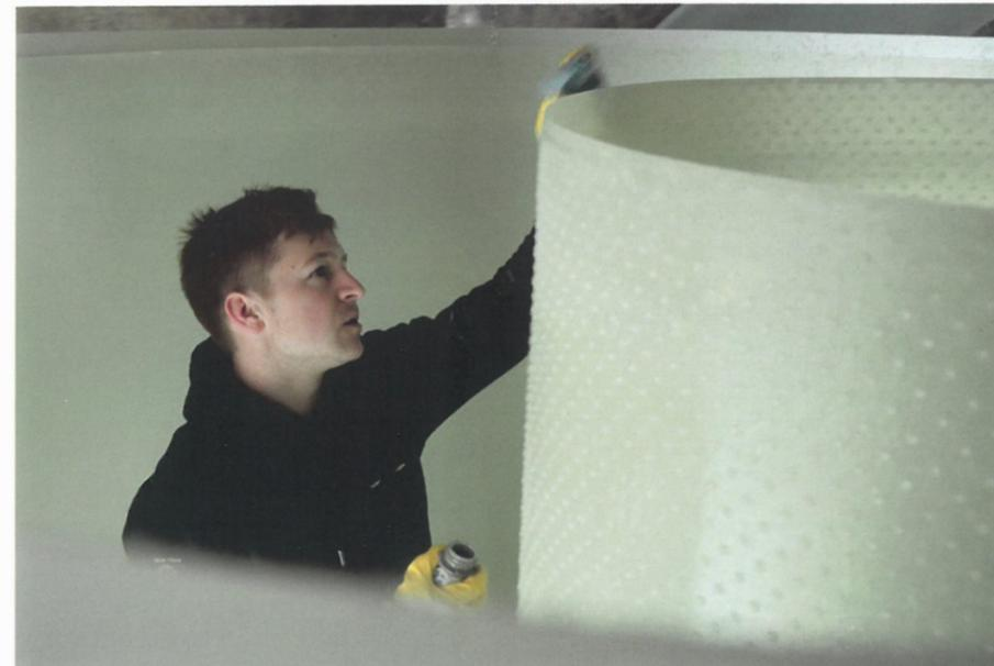
Der klassische Haase-Tank wird aus Einzelteilen vor Ort montiert.
